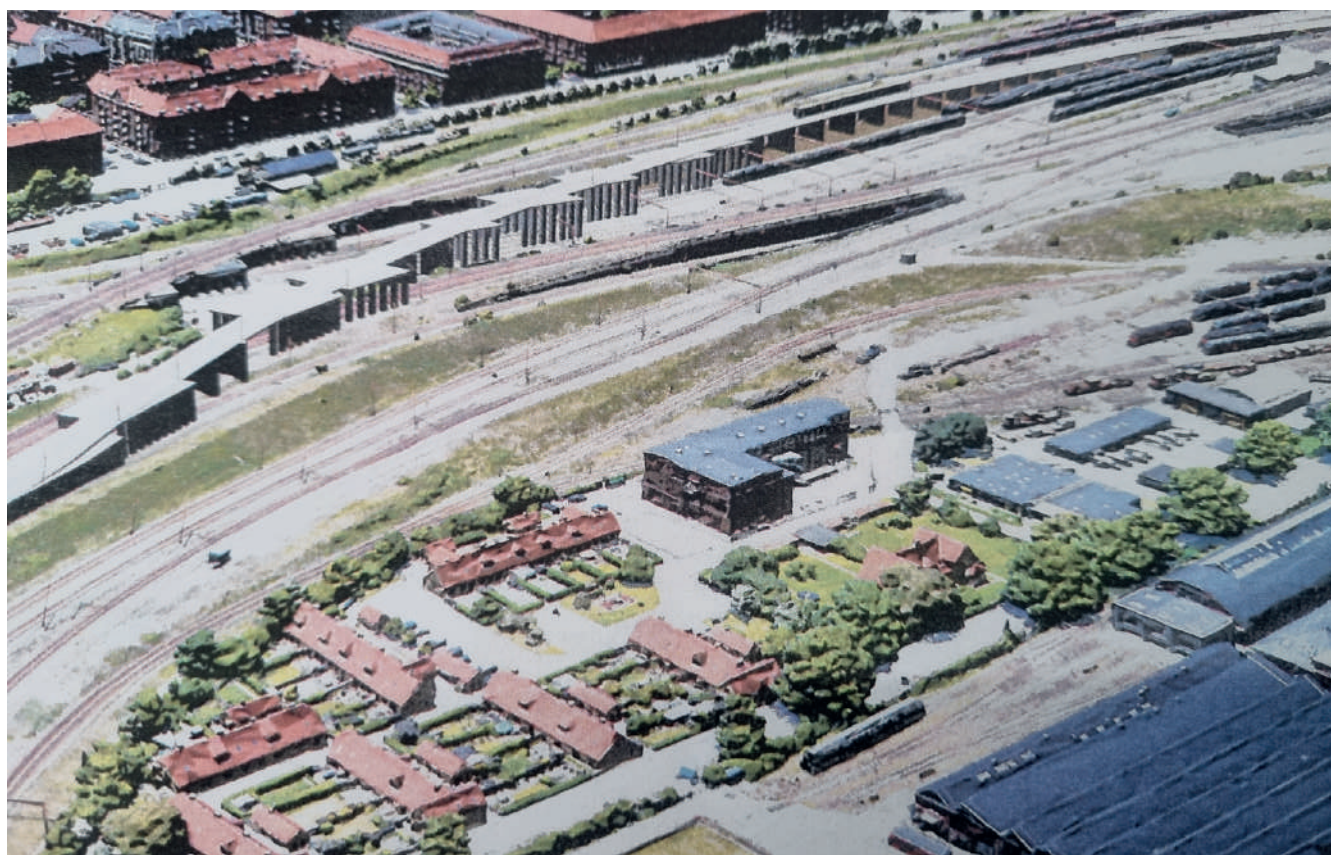
Der er muligvis en helt ny jernbanebro på vej ved Hovedbanen. Ill: Banedanmark.
